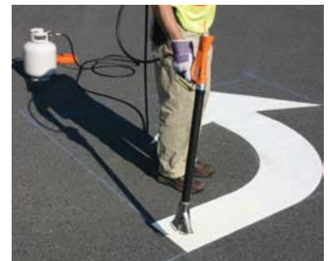
Caliente el PreMark® con una antorcha de propano como la Flint 2000EX® y haga una prueba con un cincel para asegurar una adhesión adecuada.
