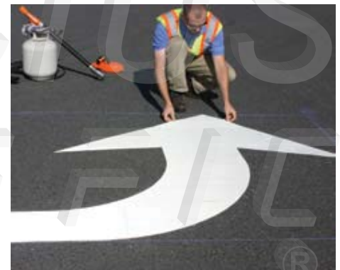
Posicione el material de PreMark® según el trazo.
